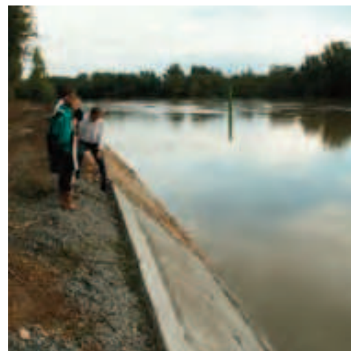
Perré en cours de restauration à Trévoux.
