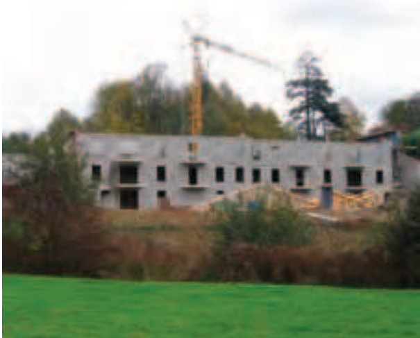
Construction de logements sociaux, à Sainte-Euphémie.
