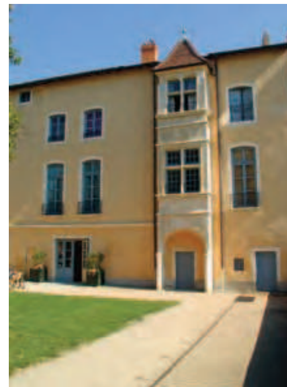
L'office de tourisme Trévoux Saône Vallée, installé au rez-de-chaussée de la maison des Sires de Villars.
