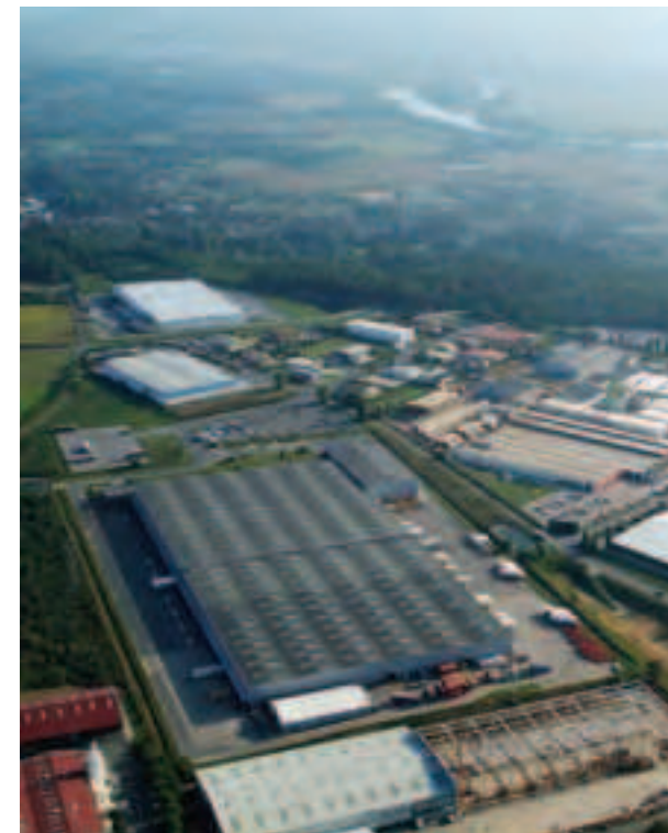
La zone industrielle de Reyrieux.
