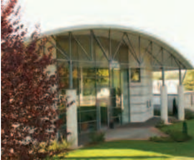
L'entreprise Extel, dans le parc d'activités de Trévoux.
