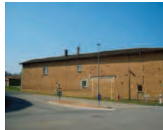
Ferme en pisé, à Toussieux. Le soubassement est en galets.
